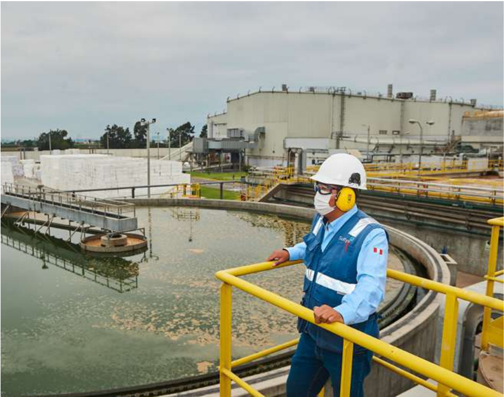
Planta de tratamiento de efluentes, en planta Cañete, Perú.
